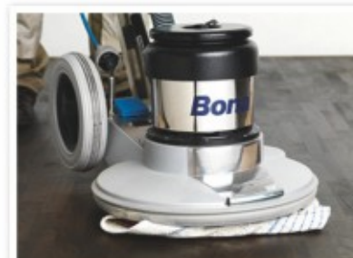
Rozleštění pomocí bavlněného hadru a talířové brusky – Pro větší lesk přeleastíme padem
